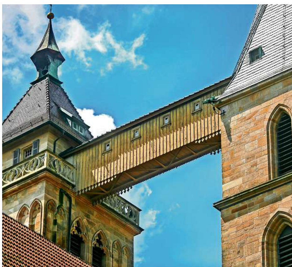
Der Verbindungssteg zwischen den beiden Türmen wird saniert.
