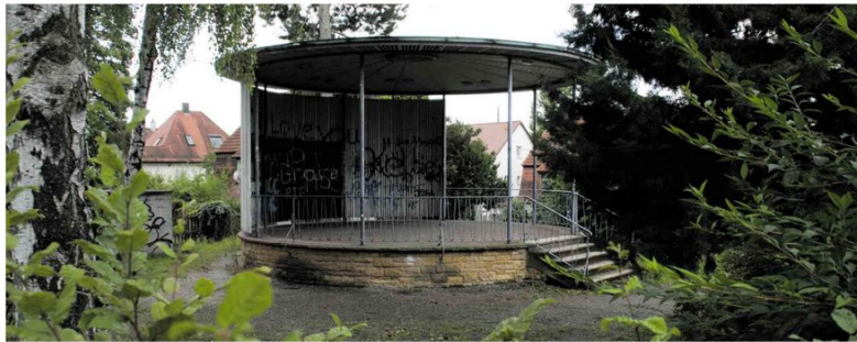
Auf der Otto-Wurster-Anlage soll in den kommenden Jahren dringend benötigter Wohnraum entstehen.
