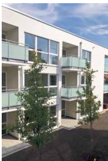
Drinnen ist alles so gut wie fertig, draußen muss noch Grün sprießen. Foto: ppr
