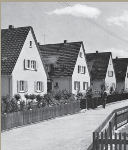
Bohnausiedlung in Kirchheim unter Teck
