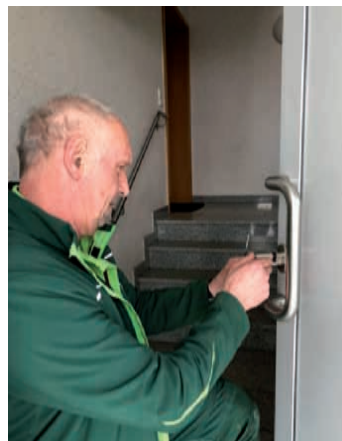
Schnelle Hilfe – Herr Sigel beim Austausch eines defekten Schließzylinders.
