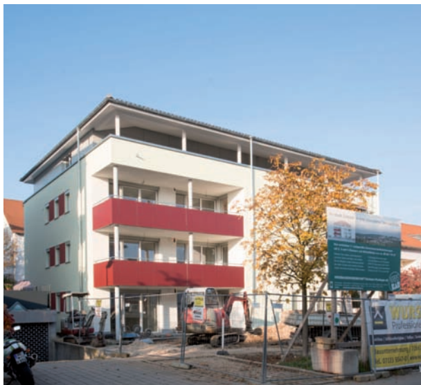
Geschwister-Scholl-Straße 15 in Plochingen
