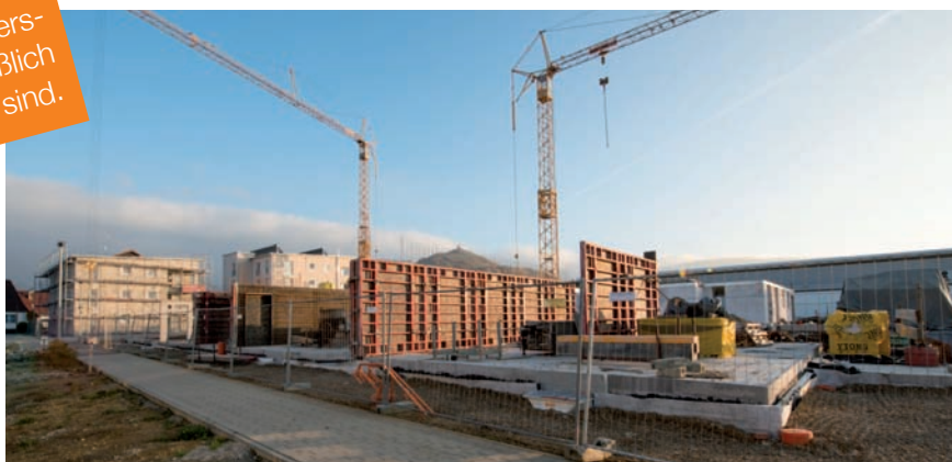
Neubau in der Karl-Fischer-Straße in Weilheim
